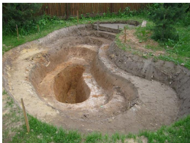
Фото 3. Конструкция пруда с ярусами для размещения растений, в центре углубление для зимовки рыб и другой живности – зимовальная яма.
