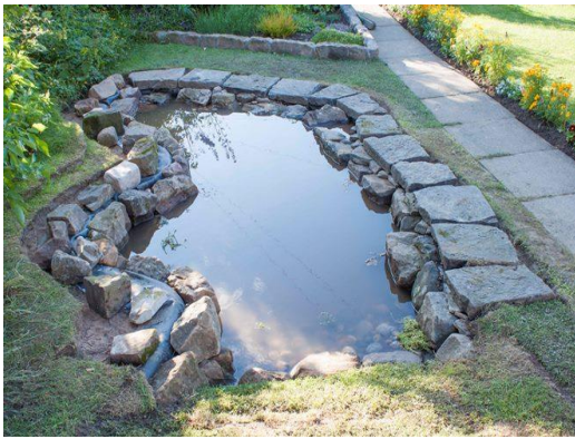
Фото 6. Крепление плёнки. По периметру котлована идет специальная траншея для крепления пленки. Края пленки хорошо фиксируются камнями.
